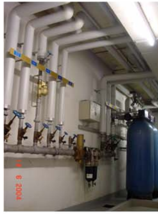
vor dem Ausbau der Salzanlage
