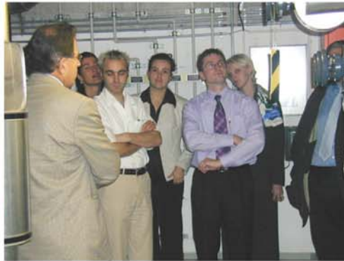
Hotel Flora Luzern Hans GÖssi erläutert die Funktion der GÖSSI-Mat Mischwasseranlage
